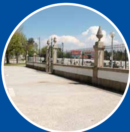
Arranjo da zona envolvente, gradeamentos e muros do Cemitério de Ferreiró, arranjo dos gradeamentos, muros e Capela Mortuária do Cemitério de Parada e melhoramento no piso dos restantes cemitérios.
