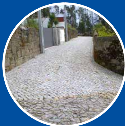
Pavimentação da Travessa da Ponte d'Áve Bagunte
