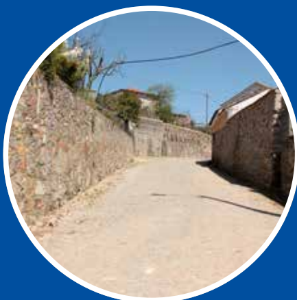
Pavimentação da Travessa do Eirado (duas partes) Ferreiró
