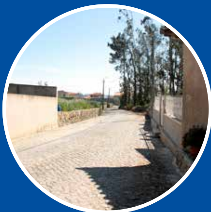
Alargamento e pavimentação da Rua de Fontelheiros Outeiro
