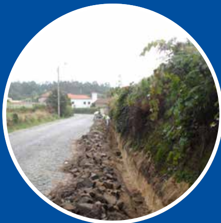
Pavimentação e drenagem da Rua Luís de Camões e da Rua de Nossa Sra. de Fátima Bagunte
