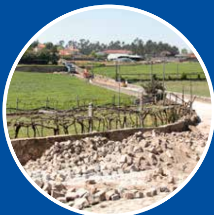
Pavimentação da Travessa da Trindade C Ferreiró
